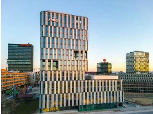
OPTINEO KPMG AG Fertigstellung 2023, 32.000 qm Geschossfläche
