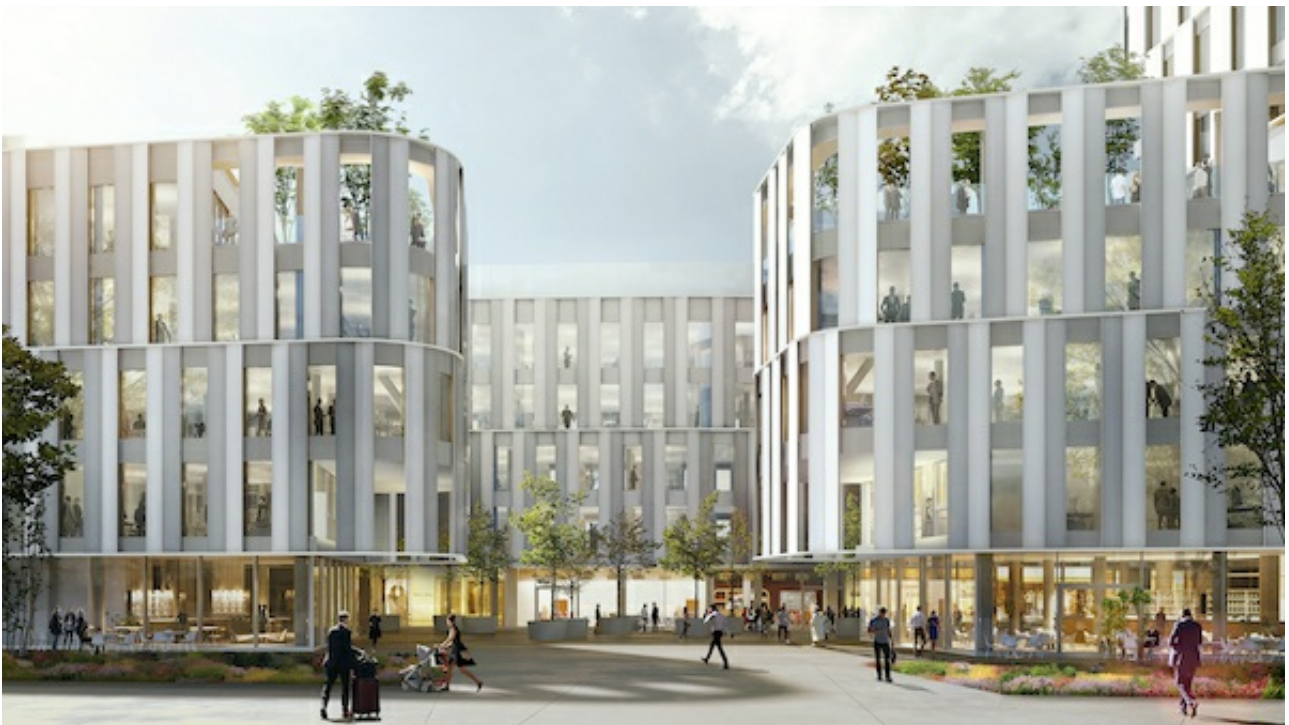
Das OPTINEO – Ansicht vom zentralen Knödelplatz im Werksviertel. © Nieto Sobejano Arquitectos / WÖHR + BAUER GmbH
