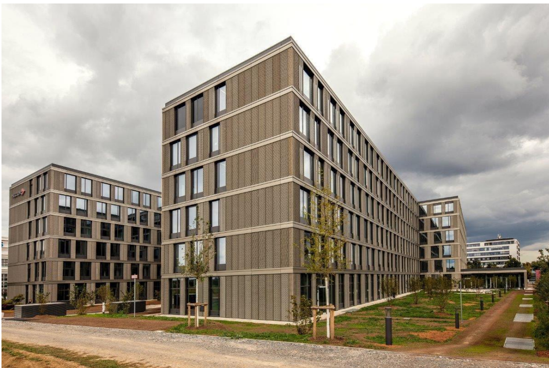
Das W9 in Stuttgart Weilimdorf nach den Entwürfen von wma Architekten, Foto: Bernd Ducke/WÖHR + BAUER
