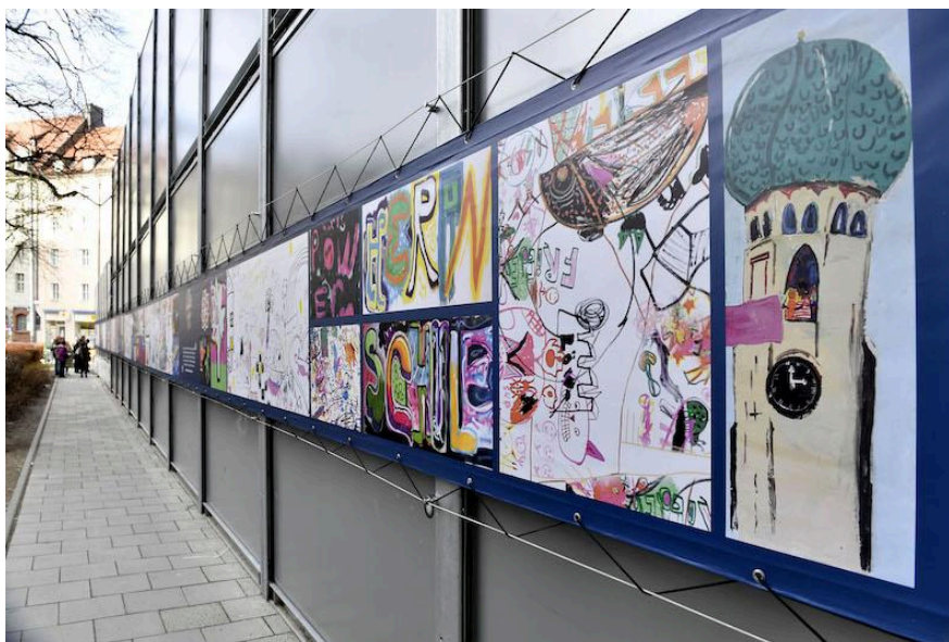
Die farbenfrohe Lärmschutzwand im Herzen der Münchner Altstadt. Fotocredit: WÖHR + BAUER
