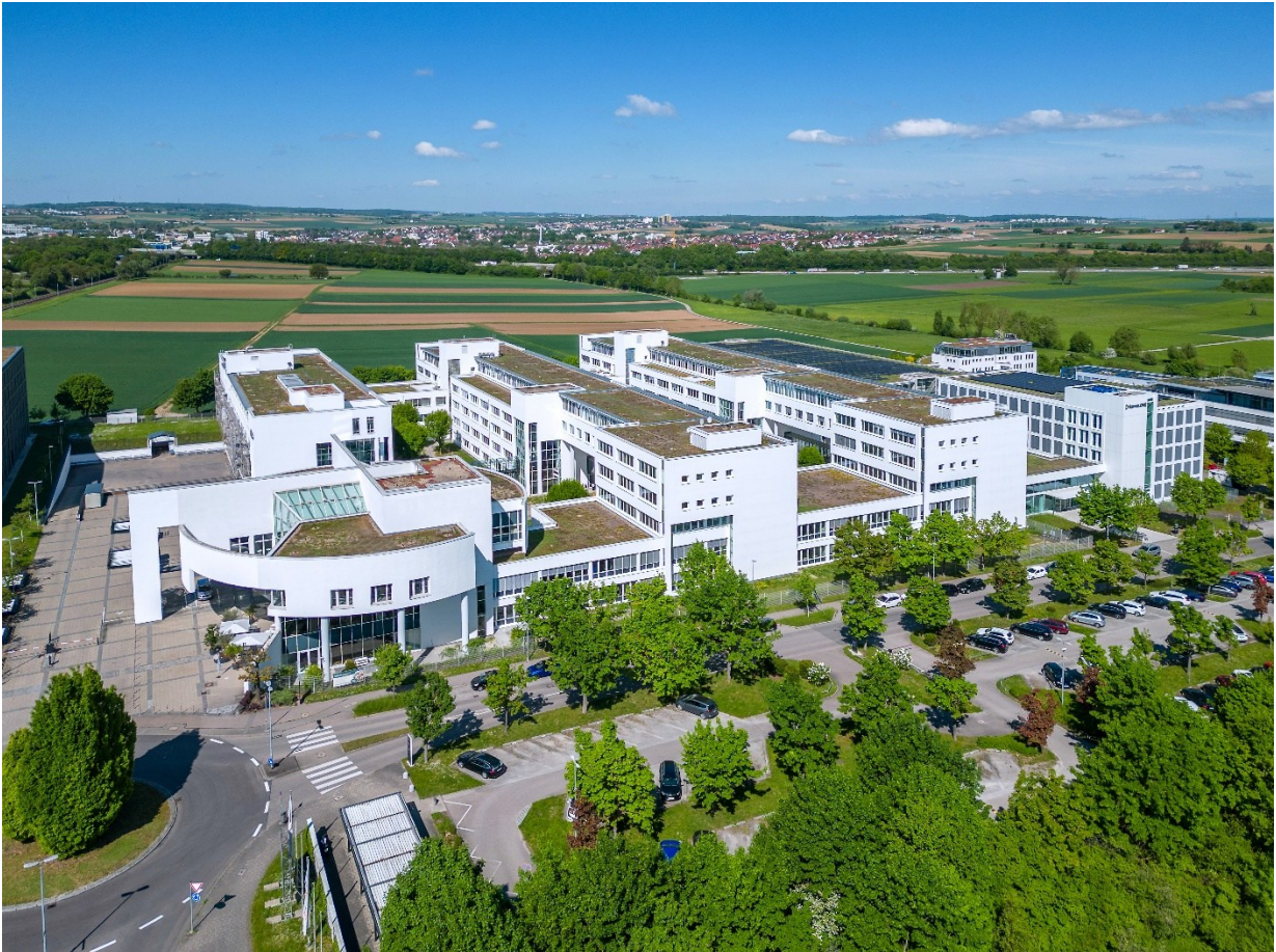
Das W11 von WÖHR + BAUER am WISSENSCAMPUS ist vollvermietet. Quelle: WÖHR + BAUER
